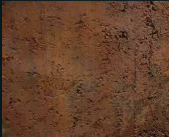
M-178 · Rusty Ructic Concrete Panel Panel Hormigón Oxidado
